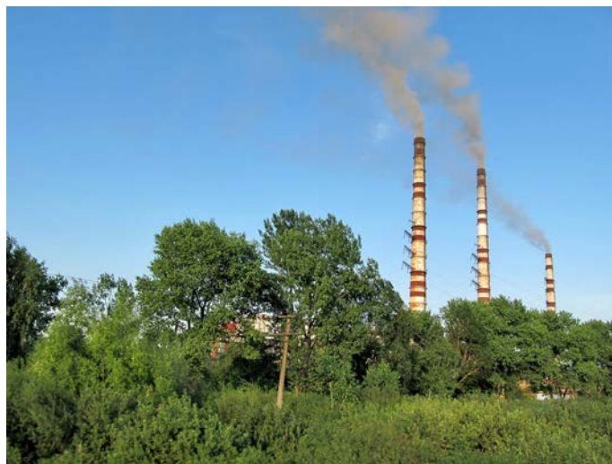
Мал. 63. Труби Бурштинської теплової електростанції
